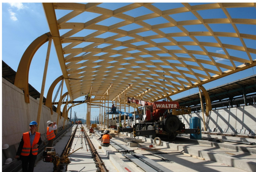
RegioTram-Haltestelle während der Bauphase (Foto: osd)
