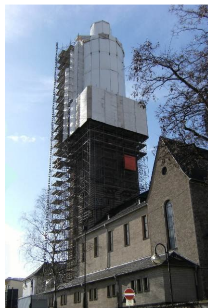
Gerüstkonstruktion Kirchturm Kerpen
