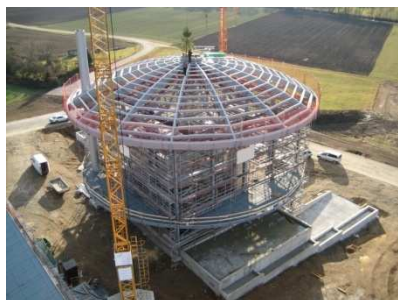
Das Biokraftwerk im Bauzustand
